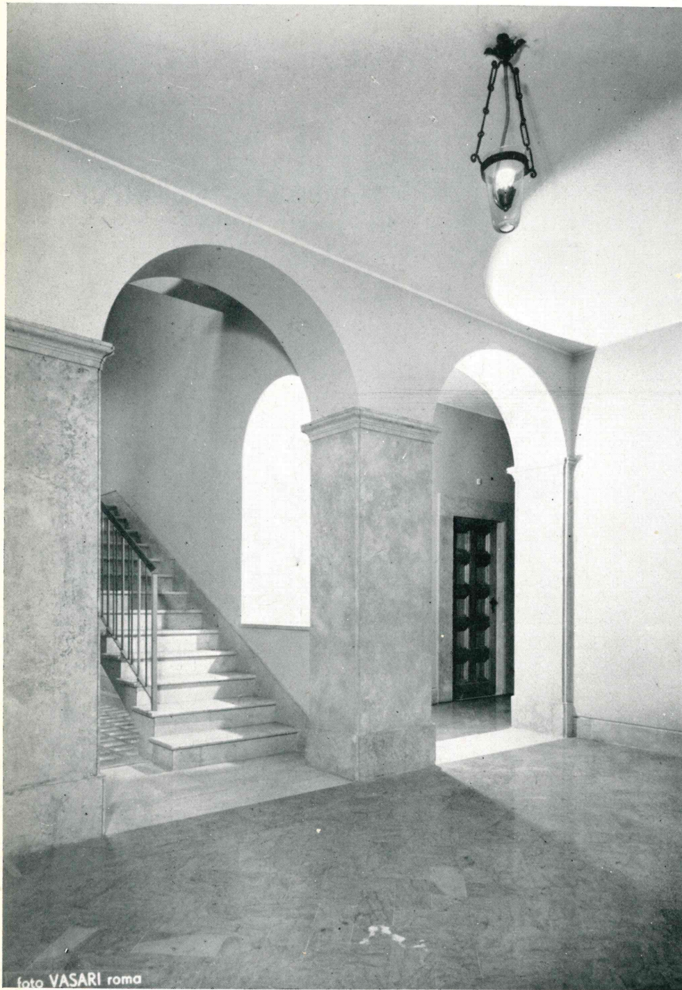
ancora due rampe per la terrazza.
